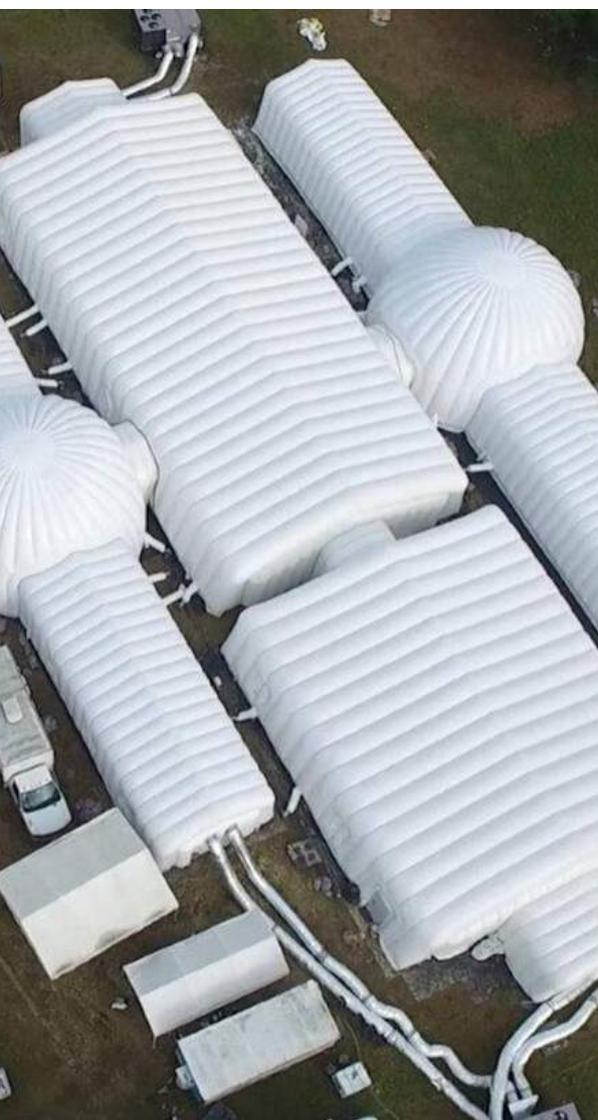
EL HMR de Campo de Mayo tiene capacidad para 28 pacientes, mientras que el de Nueva Pompeya para 24. Ambos están estructurados en módulos y en función de la emergencia pueden ser trasladados con todos sus componentes, en forma parcial o escalonada, para funcionar de manera autónoma o integrándose a otras instalaciones u hospitales.
